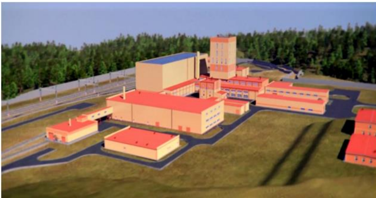
Рисунок 10. Общий вид площадки Технологического ствола
